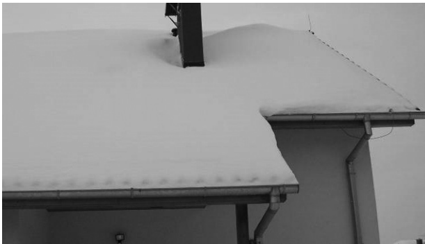
Rys. 1.3. Przykłady obciążania dachów: a) ciężarem własnym oraz pokrywą śnieżną, b) strumieniem wody opadowej
