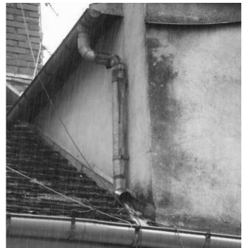
Rys. 1.3. Przykłady obciążania dachów: a) ciężarem własnym oraz pokrywą śnieżną, b) strumieniem wody opadowej
